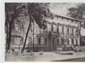
Budynek Starostwa Powiatowego – istniejący do dziś budynek przy ul. Zygmunta Starego (d. Teuchterstr.) – jego projektantem był Carl Hieronymus, a został zbudowany przed 1879 rokiem.
